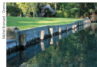
Exemples de cours d'eau dont les berges sont stabilisées. De gauche à droite, stabilisation des berges du cours d'eau par du béton, par des palplanches et par des enrochements.
