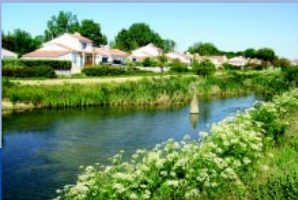
Bassin d'eaux pluviales dans un lotissement
