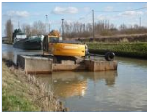
La pelle sur pontons flottants permet d'intervenir dans la partie centrale du chenal tout en limitant les nuisances. Vue de l'ensablement du chenal.
