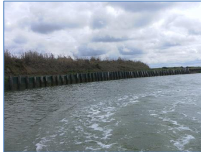
Exemples de protection en pieux battus/géogridde sur la Vertonne et l'île Bernard.
