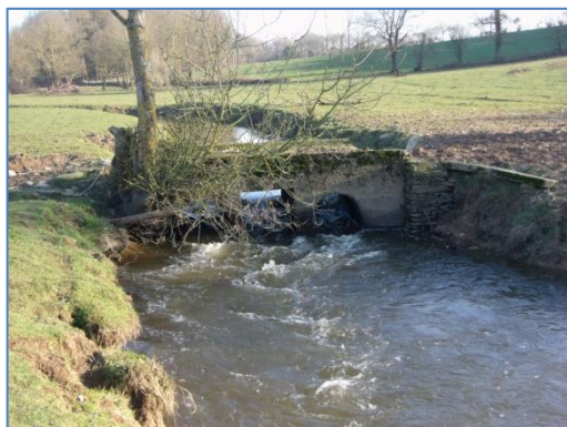
Exemples de passages busés à remplacer par une passerelle sur l'Auzance et la Vertonne.
