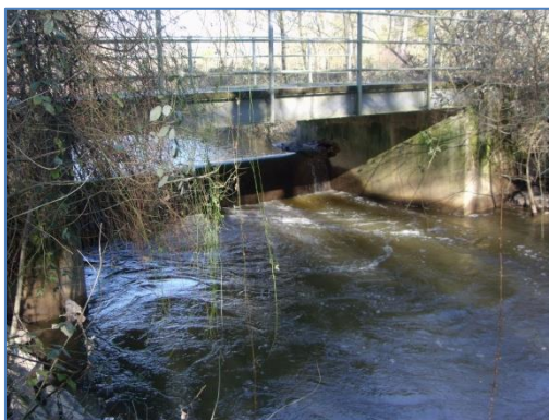
Vue du seuil jaugeur de l'Auzance
