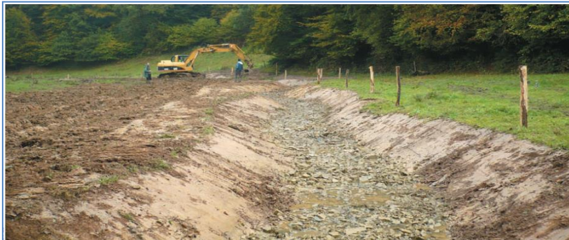
La phase de travaux de la restauration de la Doquette en octobre 2008 : reconstitution du matelas alluvial du cours d'eau par l'apport de matériaux grossiers.
