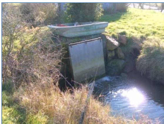
Vue aval du clapet anti-retour du marais des Cotes, dont l'usage est probablement lié au marais à poissons voisin.
