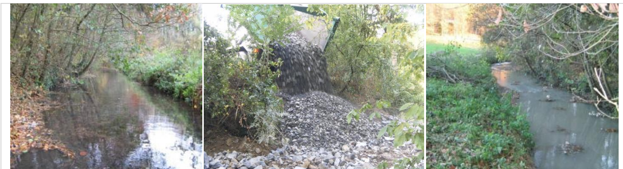
Exemple de recharge en granulats par banquette sur la Remberge (37) et la Petite Maine (85)
