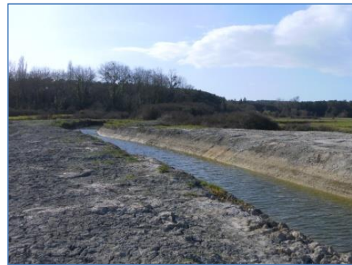
Exemple de curage récent en 2012 sur la corde Freigne (Marais des Olonnes).
