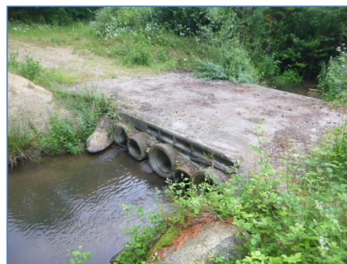
Exemples de passages busés à remplacer par une passerelle sur l'Auzance et la Vertonne.
