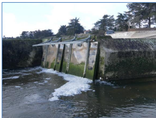
Vues du clapet et du conduit busé.
