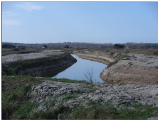
Exemple de curage récent en 2012 sur la corde Freigne (Marais des Olonnes).
