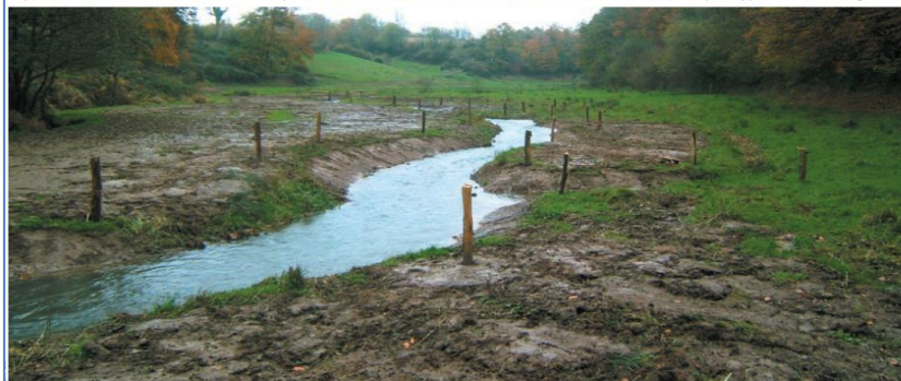
La Doquette en octobre 2008, après les travaux de restauration.
