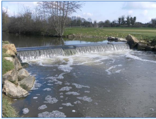
Vue aval du seuil depuis la rive droite, des enrochements ont été mis en place pour limiter les érosions de berge.
