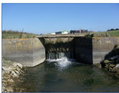
Vues amont et aval du batardeau de l'île Bernard.
