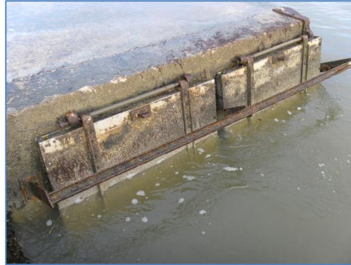
Clapet de Talmont sur le Gué Chatenay et portes à flots sur le Goulet.
