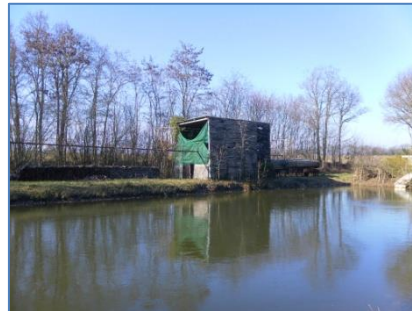
Etangs d'irrigation sur la Vertonne amont et le chenal des hautes Mers.
