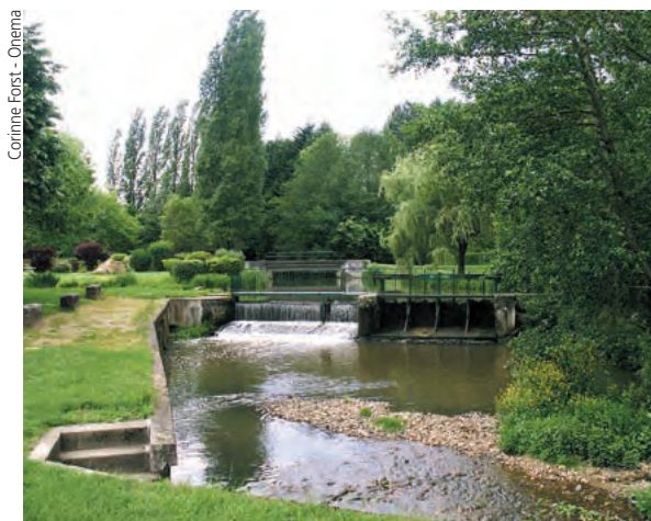
Bancs alluviaux, non mobilisables par une crue du fait de la présence d'un ouvrage transversal qui détourne une part significative du débit du cours d'eau. La végétalisation de l'atterrissement est favorisée.
