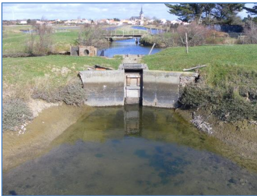
Les essailles sont principalement en béton, parfois d'autres sont en bois.
