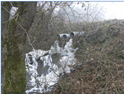
Ouvrages de trop-plein d'étangs sur le Gué Chatenay et la Ciboule amont.
