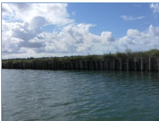
Protections de berge avec la technique des pieux battus + géotextile.
