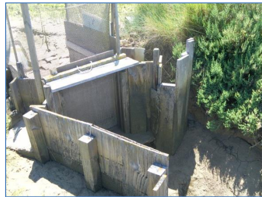
Les essailles sont principalement en béton, parfois d'autres sont en bois.
