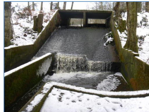
Ouvrages de trop-plein d'étangs sur le Gué Chatenay et la Ciboule amont.
