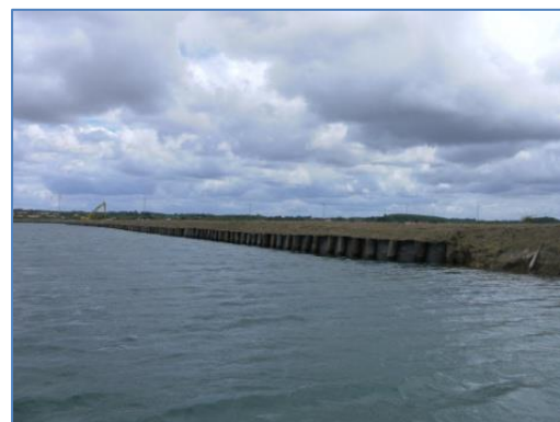
Protections de berge avec la technique des pieux battus + géotextile.
