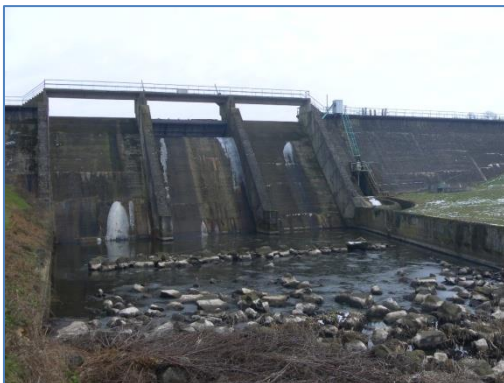
Barrage de la retenue de Finfarine et sa passe à civelles.
