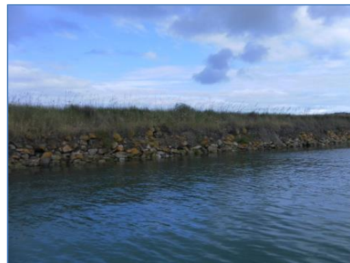
Zone d'effondrement de berge et de protection par enrochements libres.
