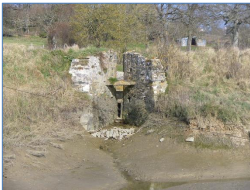
Les essailles sont souvent en pierres et dégradés et parfois plus récents en béton.
