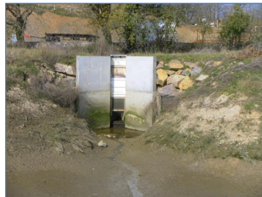
Les essailles sont souvent en pierres et dégradés et parfois plus récents en béton.
