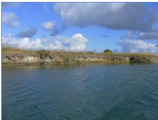
Zone d'effondrement de berge et de protection par enrochements libres.
