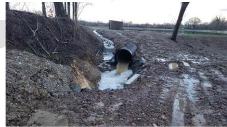
**L'aménagement en urgence du déversoir de crue a permis de limiter le risque de montée en charge et de débordement du plan d'eau**
